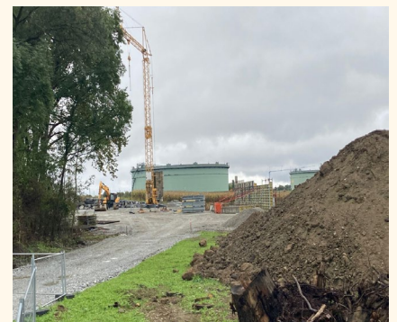
Hier entsteht das neue Biomasseheizwerk.
